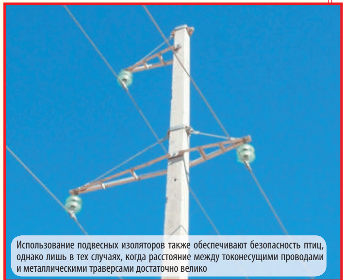
Применение современных птицевозитных устройств из диэлектрических полимерных материалов делает «ЛЭП-убийцы» почти безопасными
